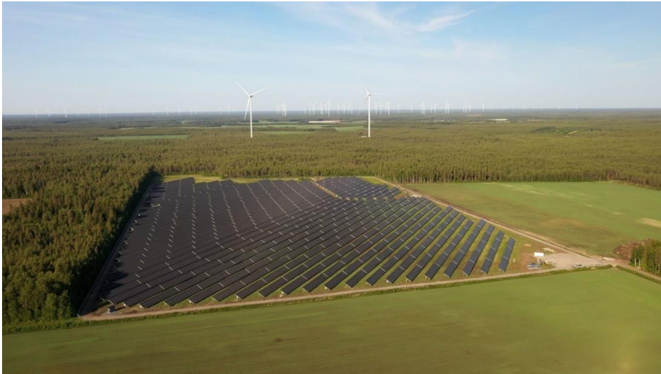
Kuva 11. Kalajoen Juurakon aurinkovoimala. (Solarigo Systems Oy, 2023)
